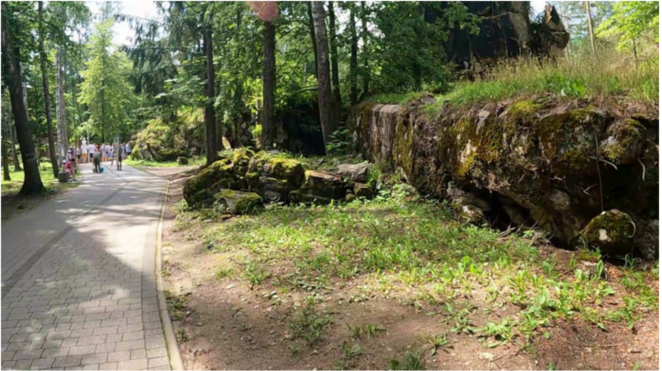
Bunkers en ruinas
