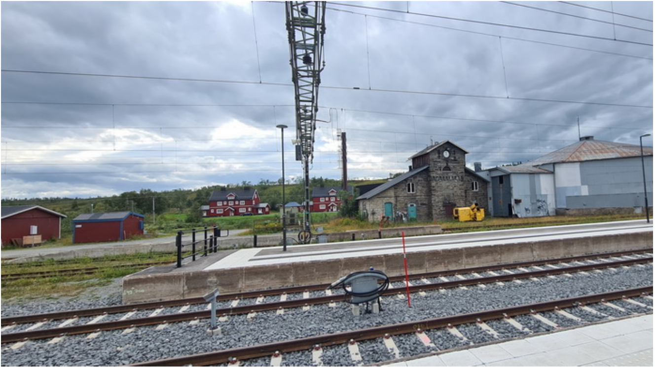
Estacion de Tren
